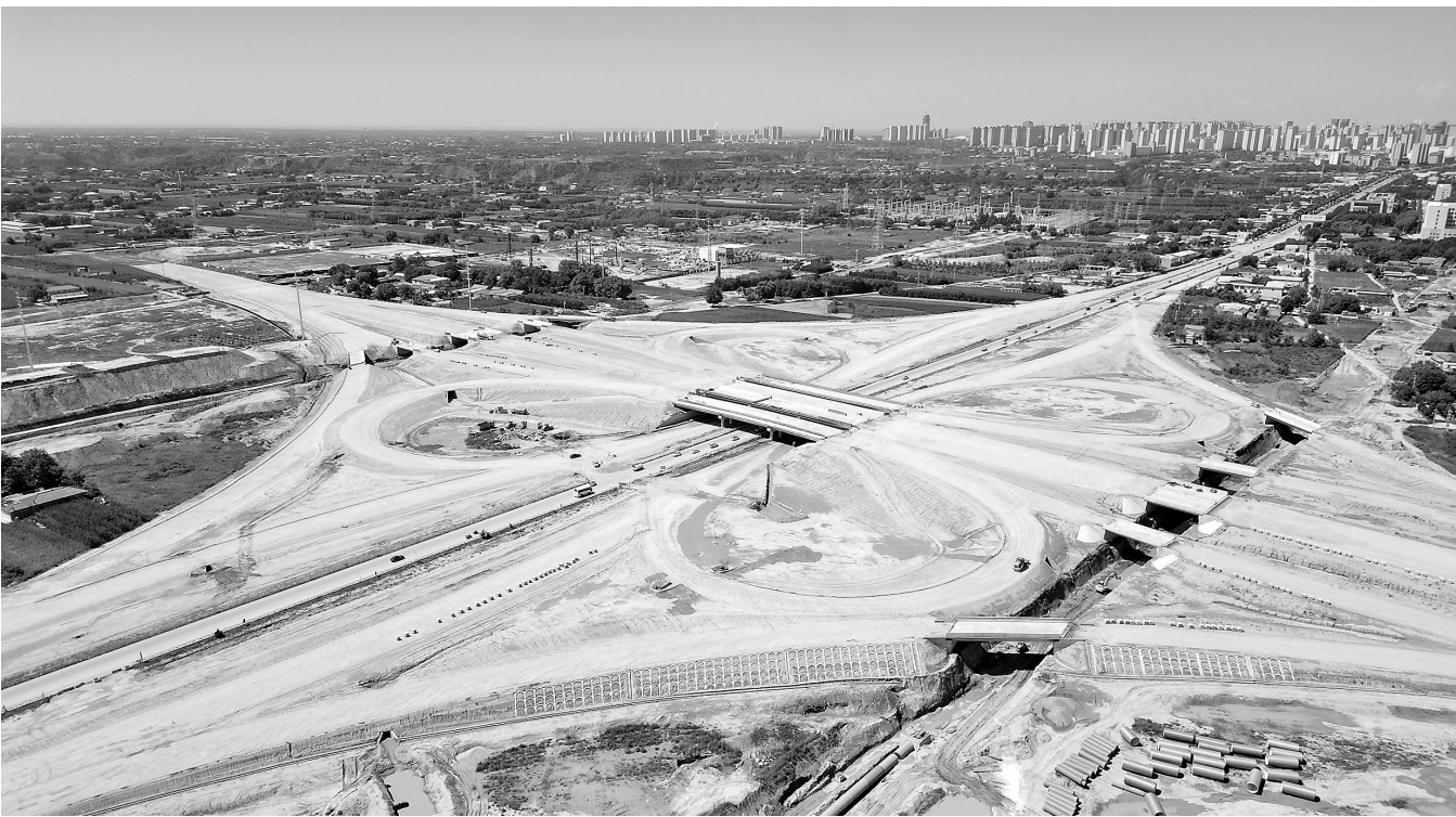
咸阳市西峰区G309线西峰东枢纽立交项目建设工作有序推进。该工程是实现西合、东绕城公路通行车辆快速转换的控制性工程。
