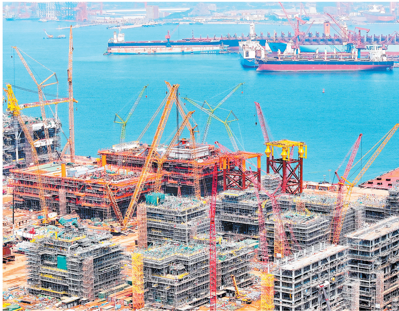
近年来,山东省持续加大海洋工程装备自主研发力度,高端装备制造不断取得新突破。图为近日在青岛海洋工程高新装备制造基地,海洋石油工程(青岛)有限公司在生产多层稠油热采平台。
