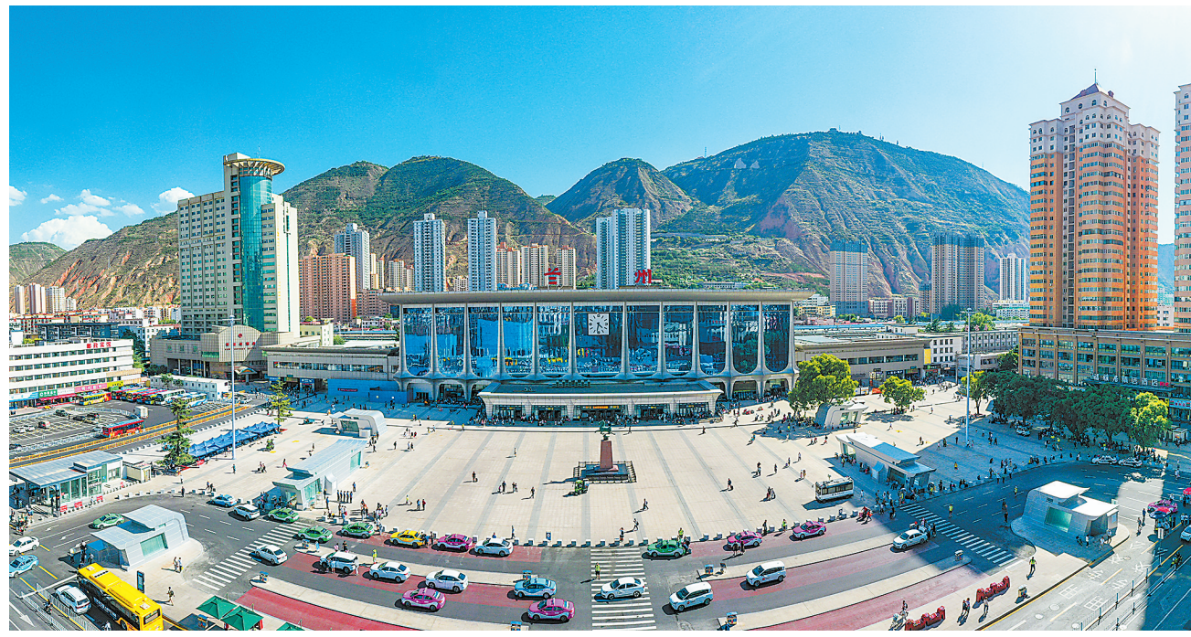
8月6日,兰州火车站站前广场改善提升项目正式完工,投入使用。
