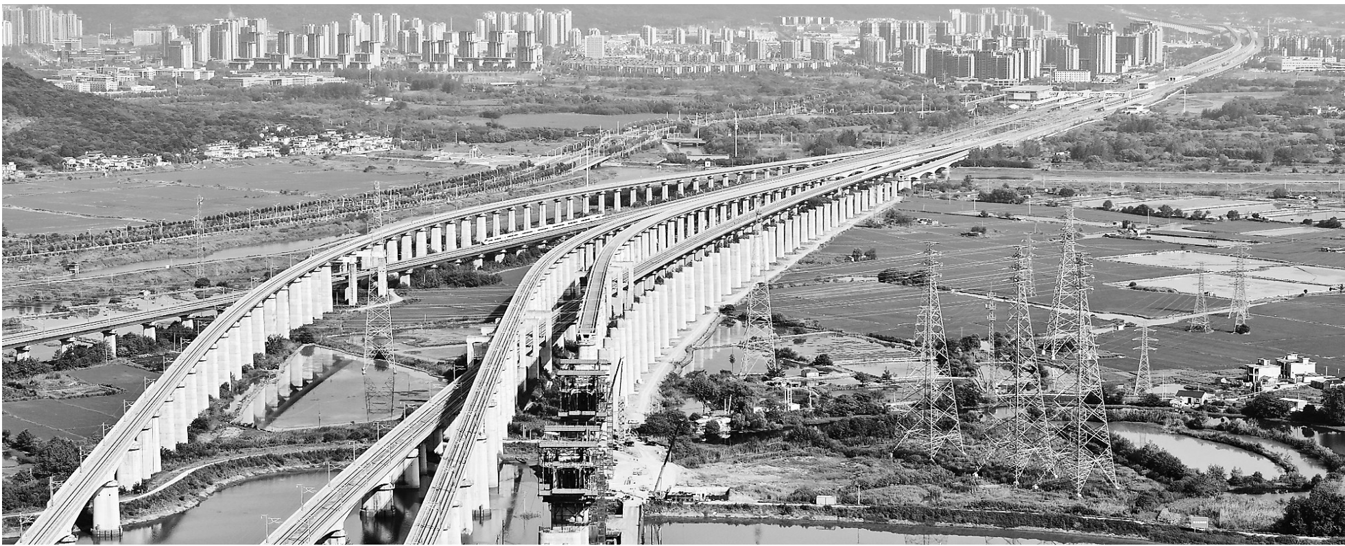
这是中铁四局渠马城际铁路清溪河特大桥施工现场(8月3日摄)。近日,中铁四局渠马城际铁路4标项目采取调整劳动作业时间、加强防暑降温等措施,保障重点工程建设有序推进。渠马城际铁路是国家“八纵八横”高铁网沪汉蓉快速通道合肥至上海间的重要组成部分,设计时速350公里。
