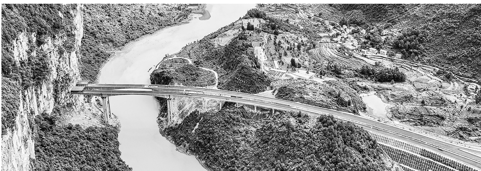
渝湘复线高速彭水路段阿蓬江大桥建设现场(8月2日报)。新华社发
