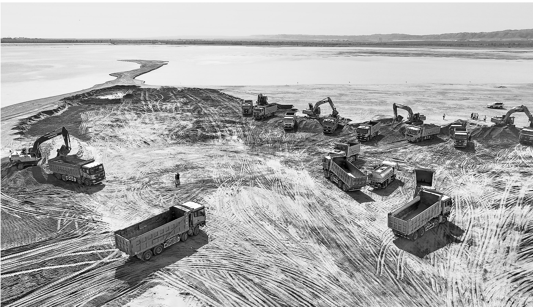
连日来，在全塔县解放村水库清淤工程现场，大型机械正在实施清淤作业。该工程完成后，可以提高解放村水库的有效库容，提升水库防洪、灌溉能力。
