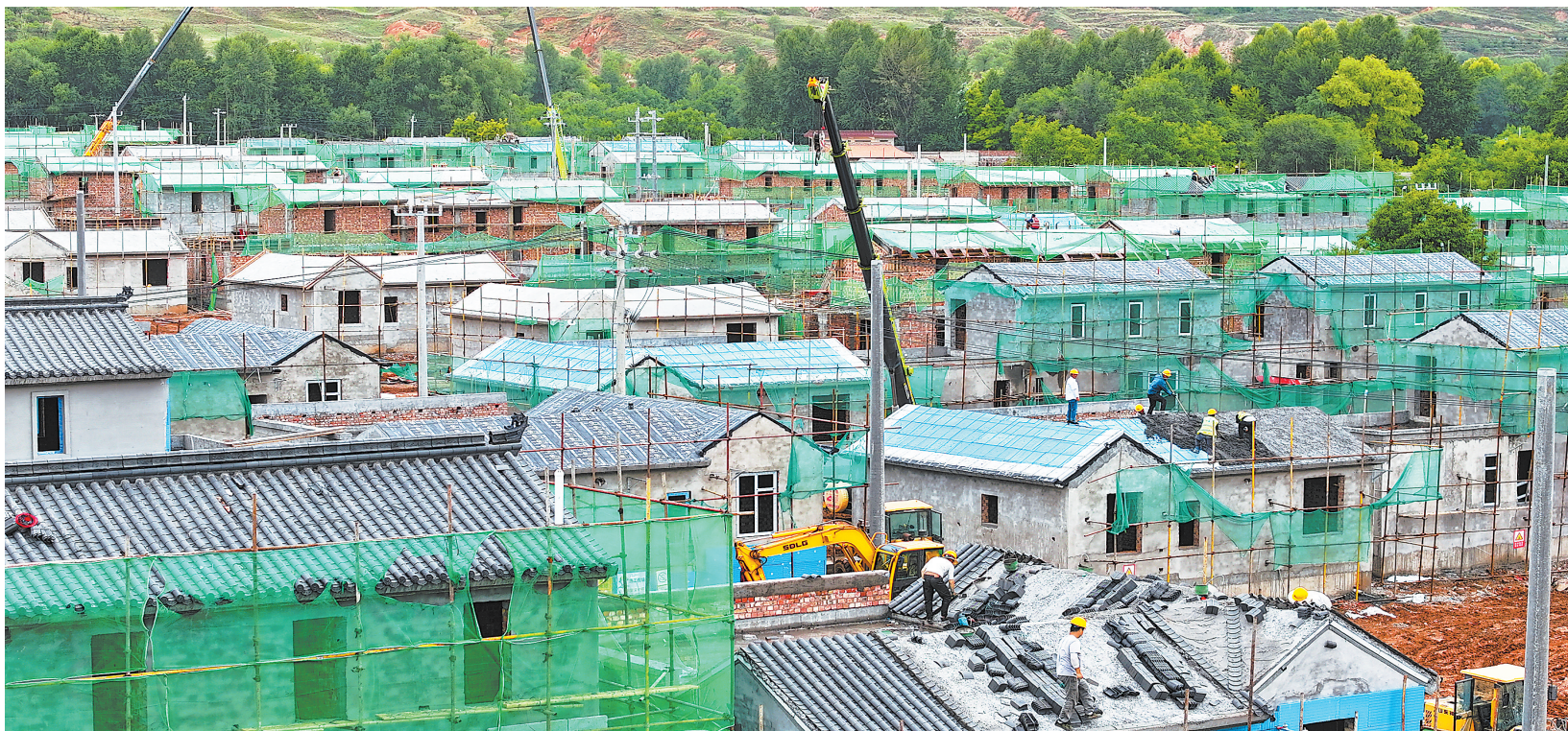
大河家镇陈家村灾后恢复重建集中安置点项目建设现场。
