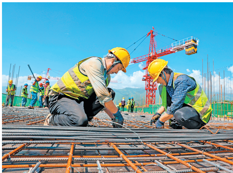
工人正在精心施工。
