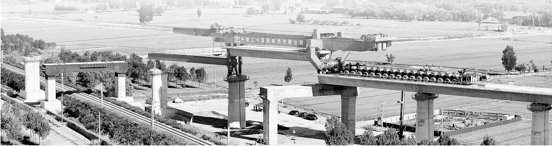
近日,在(济(南)滨(州)高铁高惠滨2号特大桥,中铁二十四局的工作人员在进行架梁作业。
