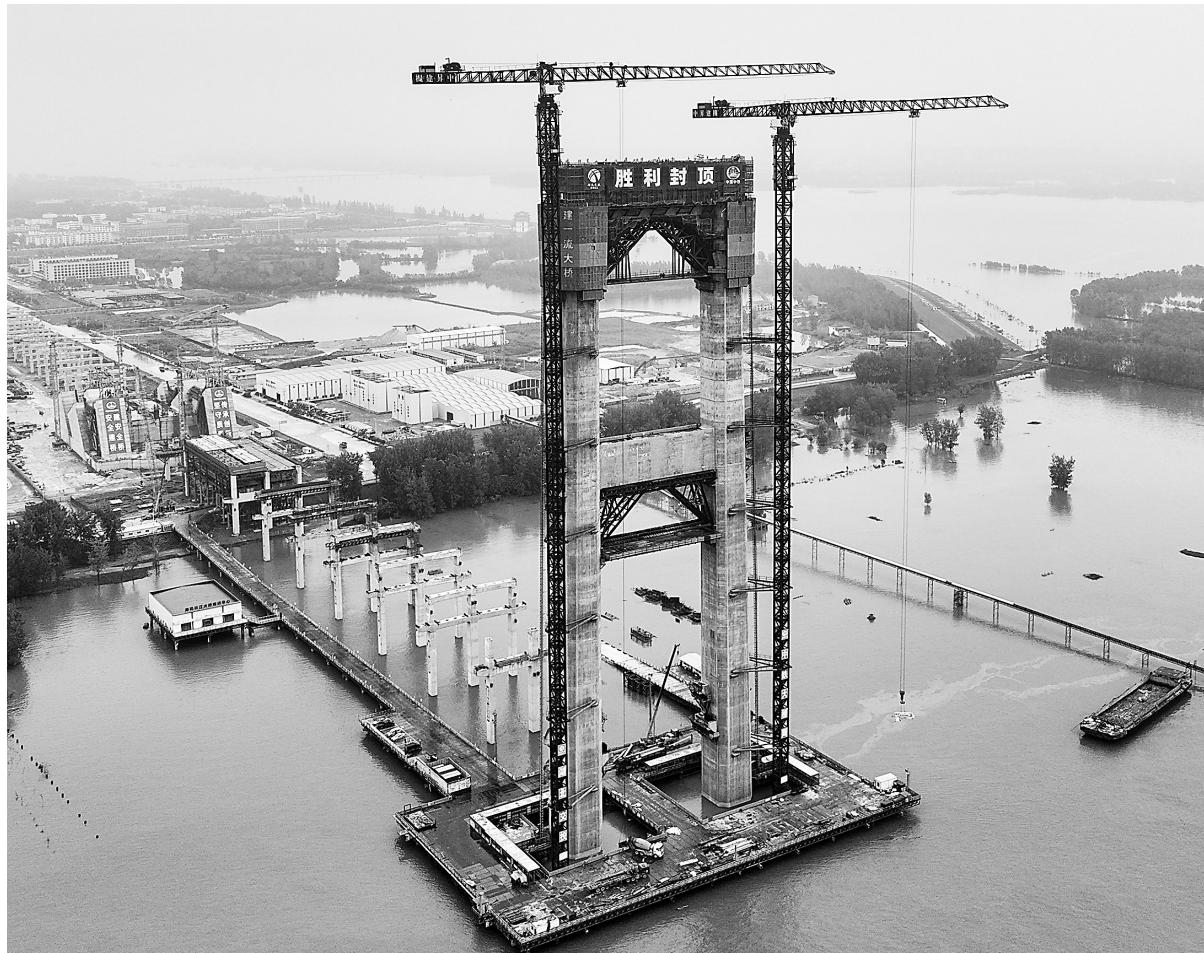
7月14日拍摄的武汉长江大桥主塔施工现场。武汉长江大桥是鄂东空铁、空陆联运立体交通运输体系的重要过江通道，也是推动黄冈、鄂州、黄石三市跨江联动开发，促进三市一体化发展的关键工程。
