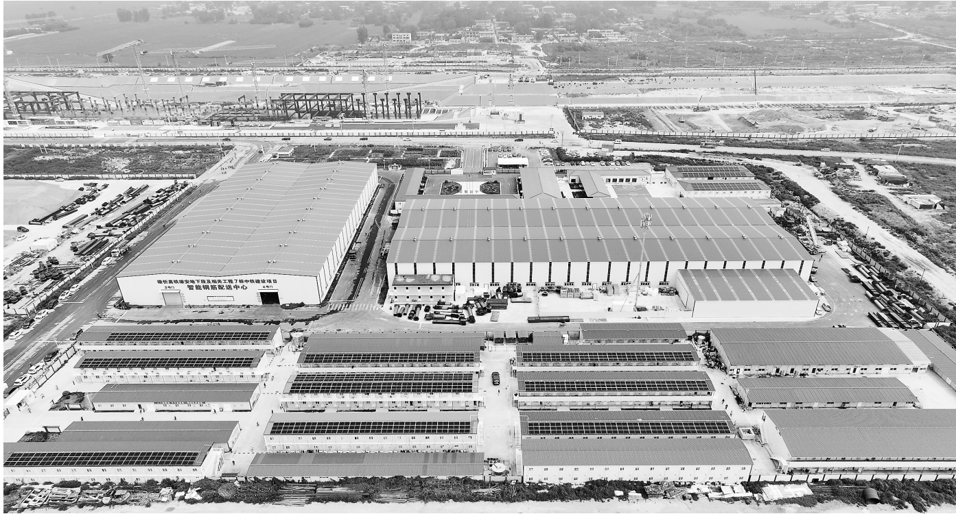
日前,雄忻高铁雄安地下段及相关工程7标项目临建光伏系统正式投运。作为雄安新区首个“光伏+临建”低碳运行管理试点项目,该光伏电站采用“削峰平谷”模式,单月可节省电费约26%,助力施工企业降本增效。
