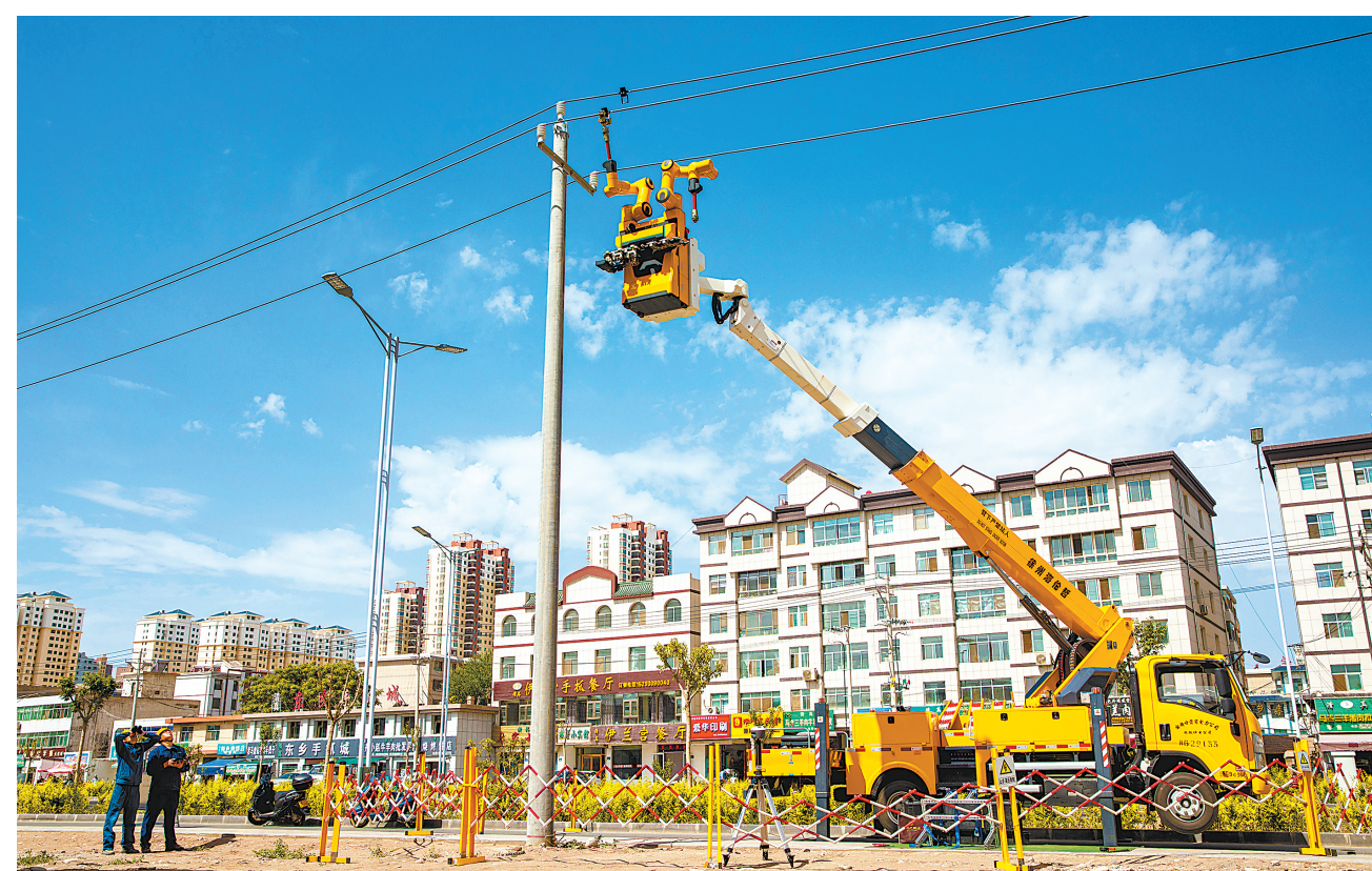
7月10日,国网张掖供电公司开展机器人带电安装接地环作业。
