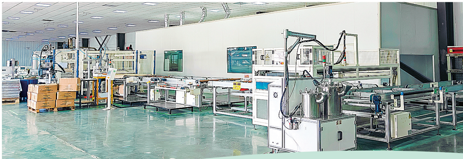
嘉峪关光伏组件智慧工厂建设项目。
