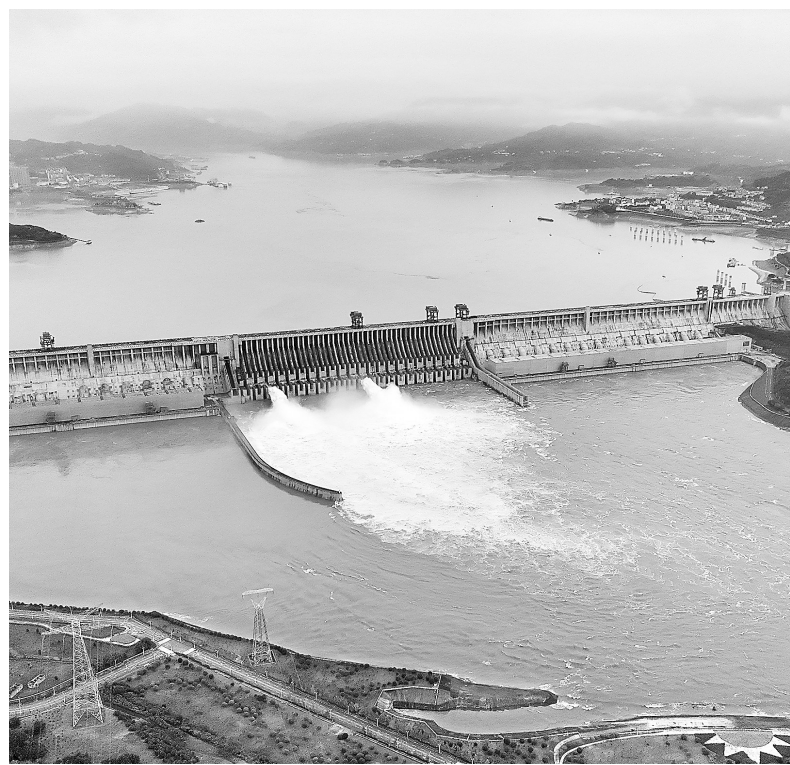
7月10日，长江三峡枢纽开启泄洪深孔泄洪。这是三峡水库今年首次开闸泄洪。新华社发
