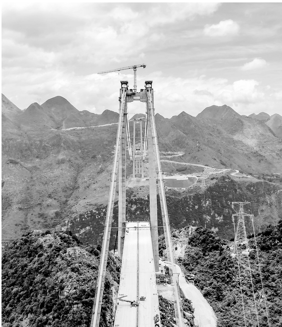
7月7日拍摄的建设中的花江峡谷大桥。花江峡谷大桥是贵州六安高速公路的控制性工程,大桥建成后,将超越北盘江大桥,成为世界第一高桥。
