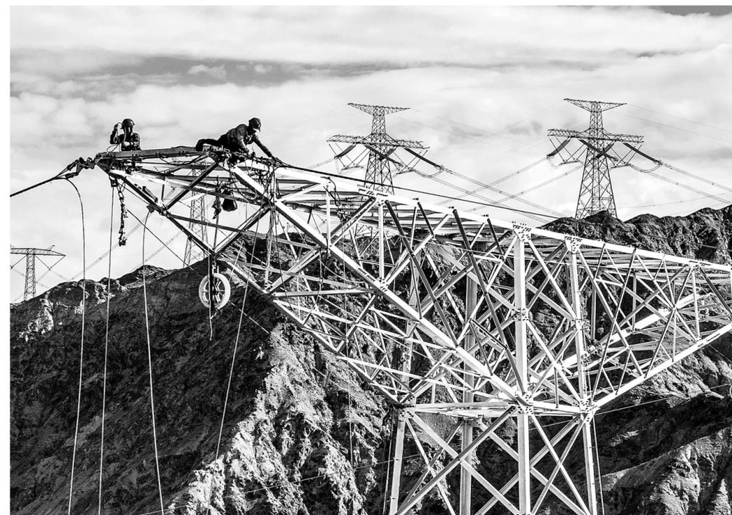
近日,在哈密—重庆±800千伏直流特高压输电线路工程甘州段2017号铁塔上,电力工人正在进行设备安装作业。该特高压输电线路工程是我国“西电东送”重点工程,线路总长约2300公里。
