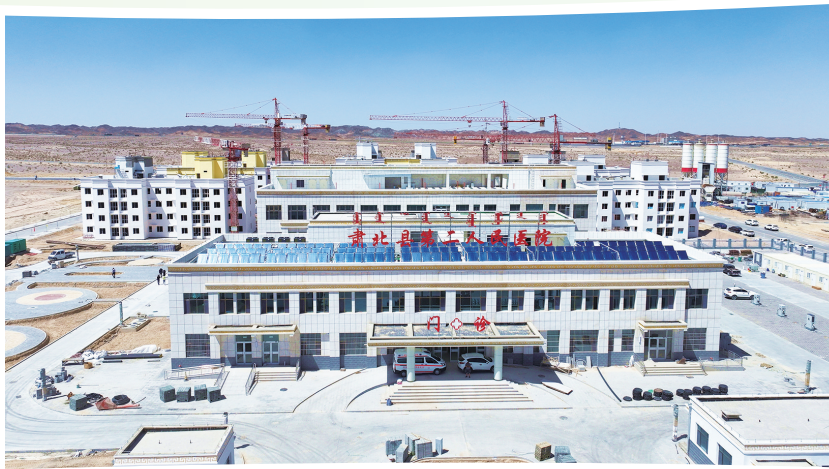
肃北县第二人民医院建设项目即将竣工。 额尔登曲龙
