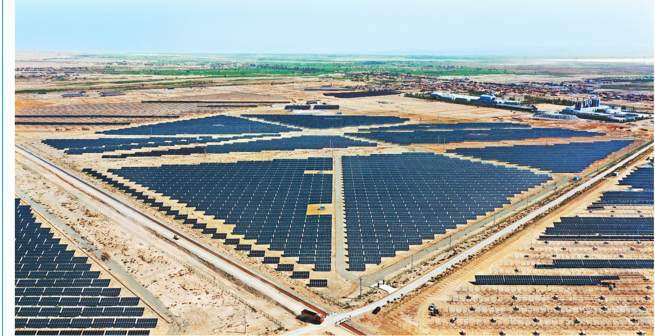
景泰县光伏帮扶电站。新甘肃·甘肃日报记者 田强
