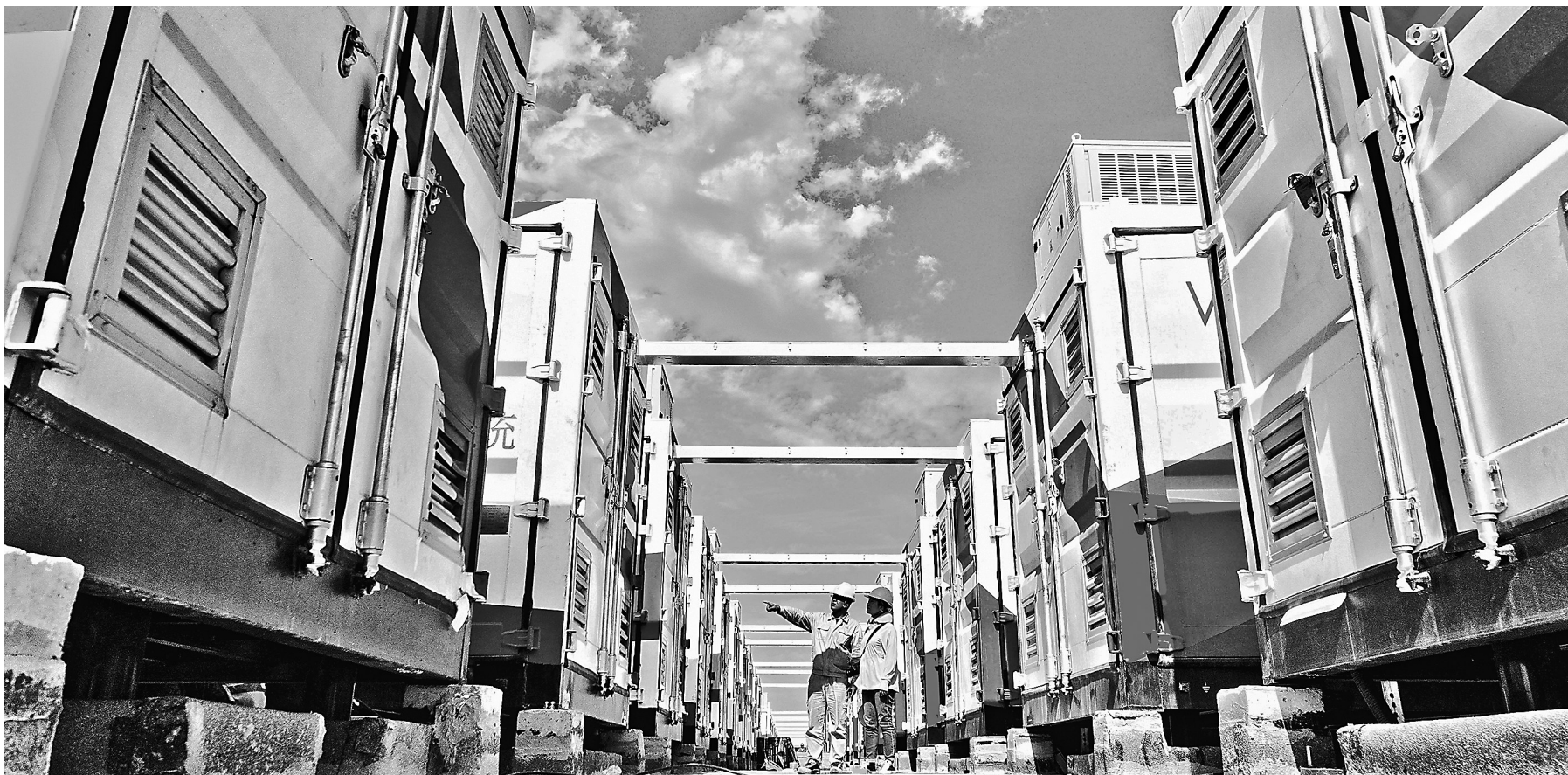
近日，在山丹县中昂能源科技有限公司储能项目现场，工人们正在安装调试储能设备。
