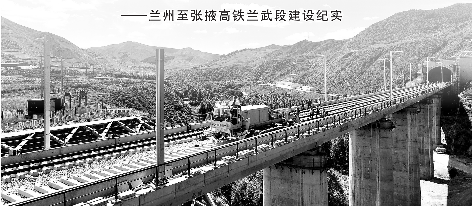
2023年，兰张高铁兰武段铺轨至新乌鞘岭隧道出口。
