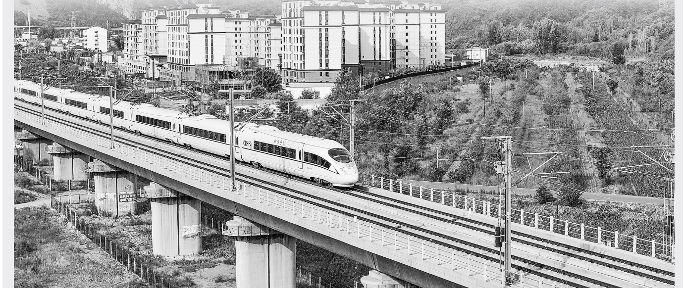
7月1日,一城际列车行驶在京哈高铁河北省承德市承德县境内。新华社发
