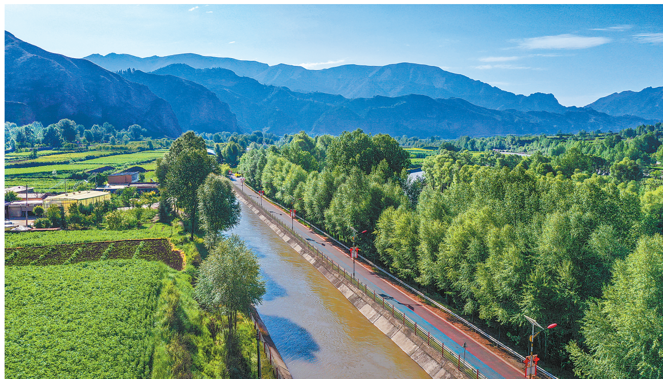
夏至时节,武威市天祝县引大入秦工程渠首枢纽,树木青郁,绿草葱茏,一派生机勃勃的景象。新甘肃·甘肃日报记者 丁凯
