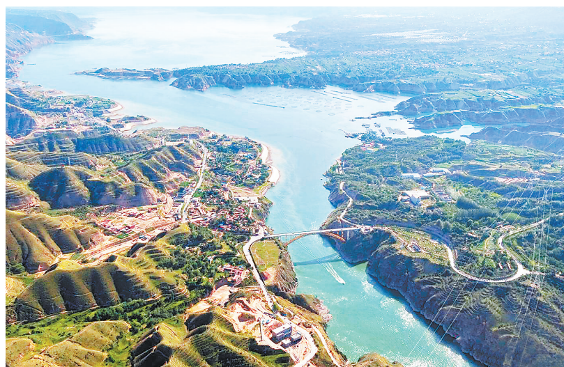
刘家峡水电站
