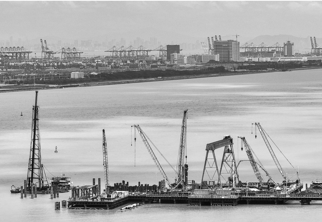
6月21日,万龙大桥主墩桩基进行混凝土浇筑施工。当日,世界最大跨度自锚式悬索桥——万龙大桥主墩桩基施工全部完成,工程将进入水上施工阶段。位于广州南沙区的万龙大桥跨越珠江口龙穴南水道,全长5146米,主桥长1150米,主跨608米,为粤港澳大湾区又一世界级桥梁。新华社发
