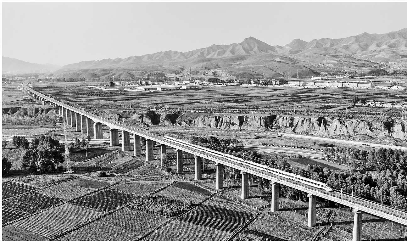
6月18日至21日,兰张高铁兰武段进入运营安全评估阶段,本次评估是列车开通前验收工作的最后一个节点。
