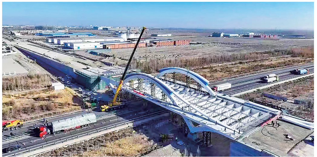
建设中的金港路上跨清嘉高速桥梁。
