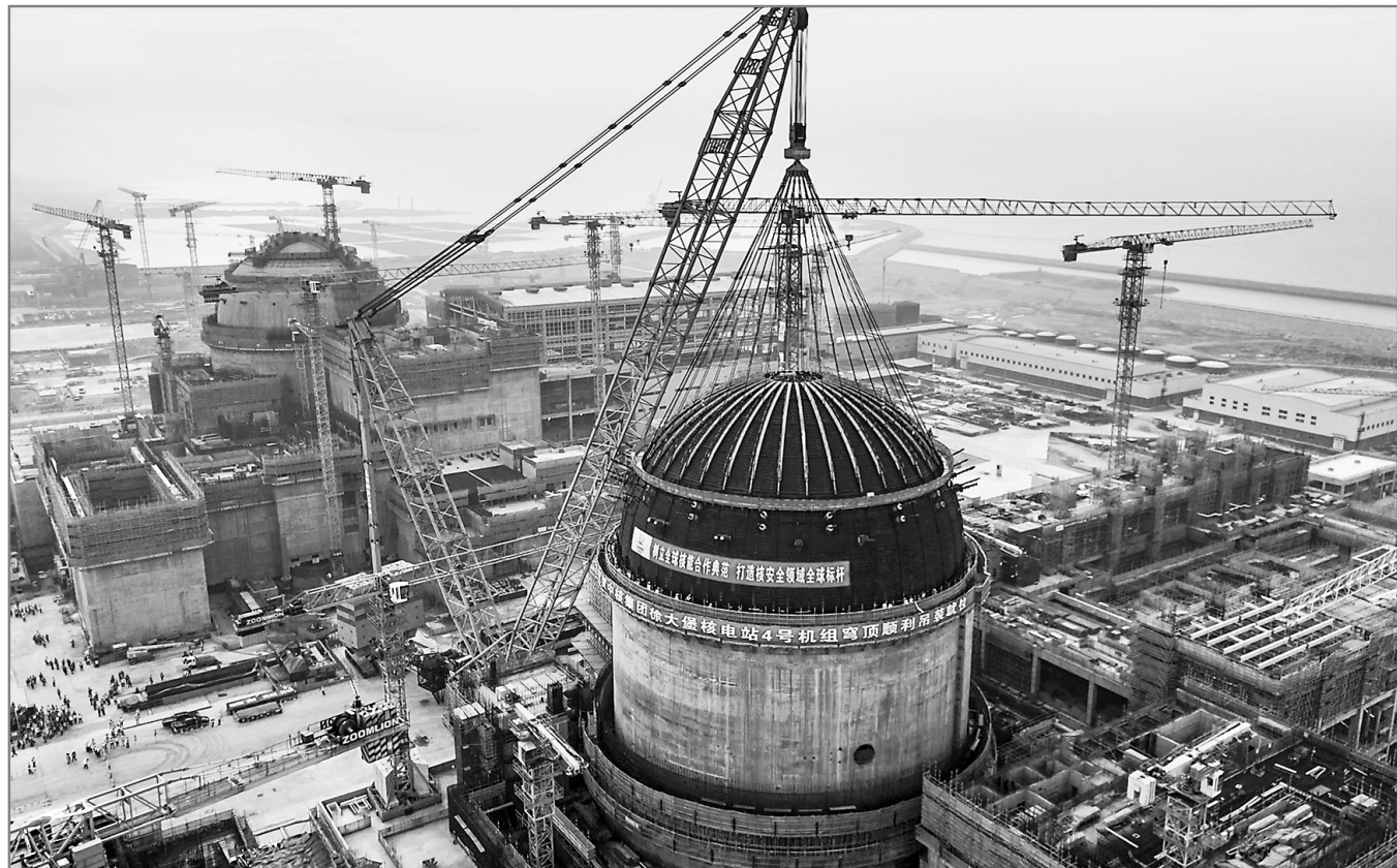
6月18日拍摄的徐大堡核电站4号机组穹顶吊装作业现场。当日,位于辽宁省葫芦岛市的徐大堡核电站4号机组顺利实现穹顶吊装就位,为进一步推进工程建设奠定基础。
