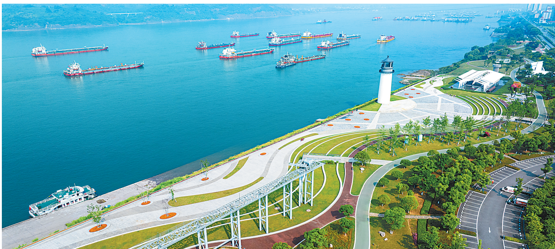
图为湖北宜昌市滨江公园灯塔广场。该广场是在实施岸线复绿等综合措施后,由老旧码头改造而成。
