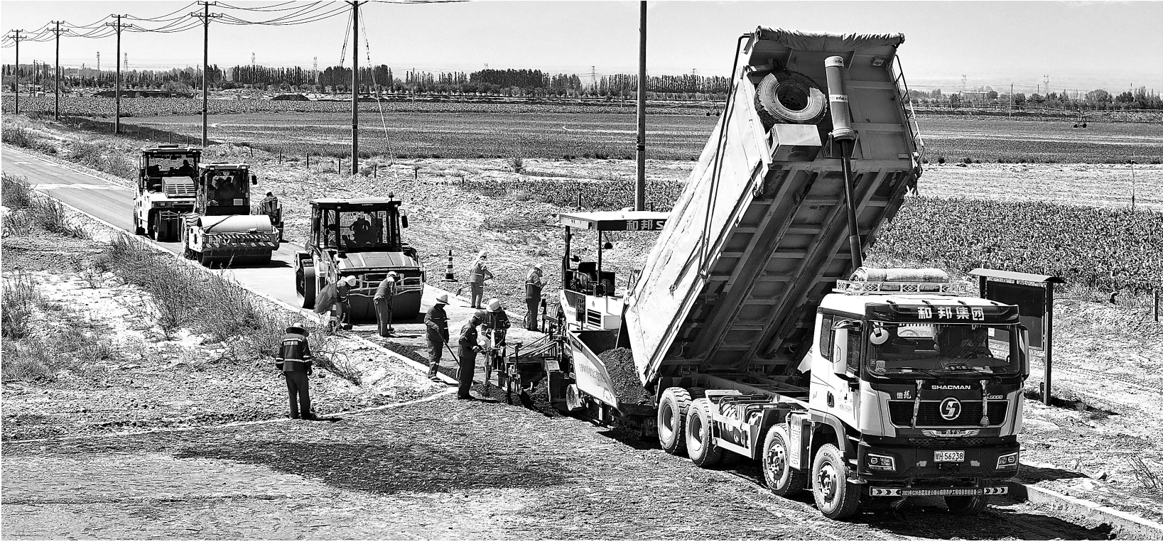
近日,民乐县产业路建设项目施工现场,摊铺机、压路机、运输车等车辆机械来回穿梭,一派繁忙景象。这条道路建成后将在很大程度上方便当地群众的出行和农产品运输。 新甘肃·甘肃日报通讯员 王晓廷 吕涛
