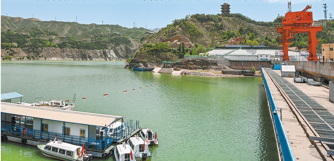
刘家峡水电站大坝。 本组照片均为新甘肃·甘肃日报记者 丁凯 摄
