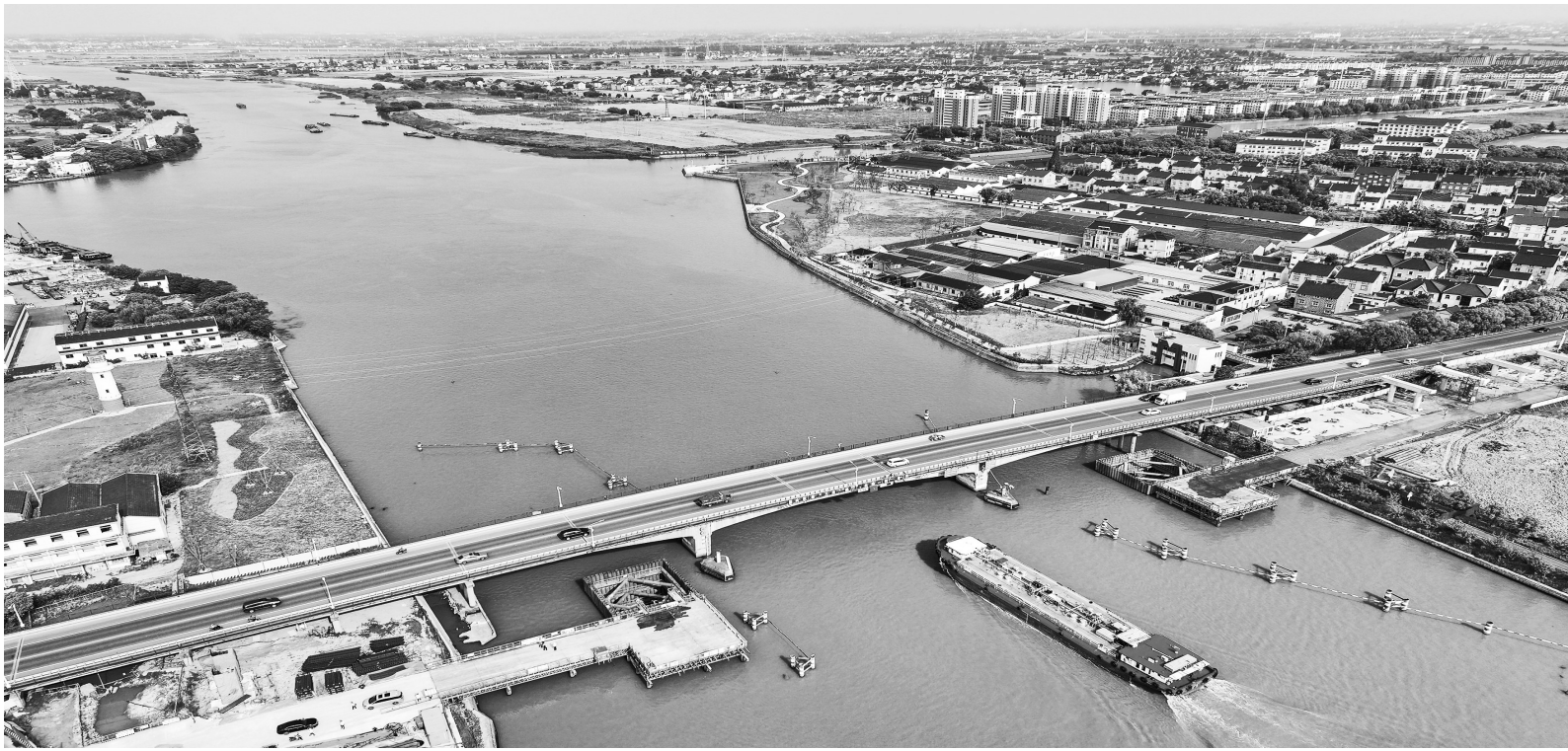
6月4日拍摄的长湖申线(江苏段)航道整治工程东段项目施工现场。目前,航道整治工程有序推进,项目整体建成后,对构建长三角高等级航道网、完善区域综合交通运输体系等具有重要意义。 新华社记者 季春鹏
