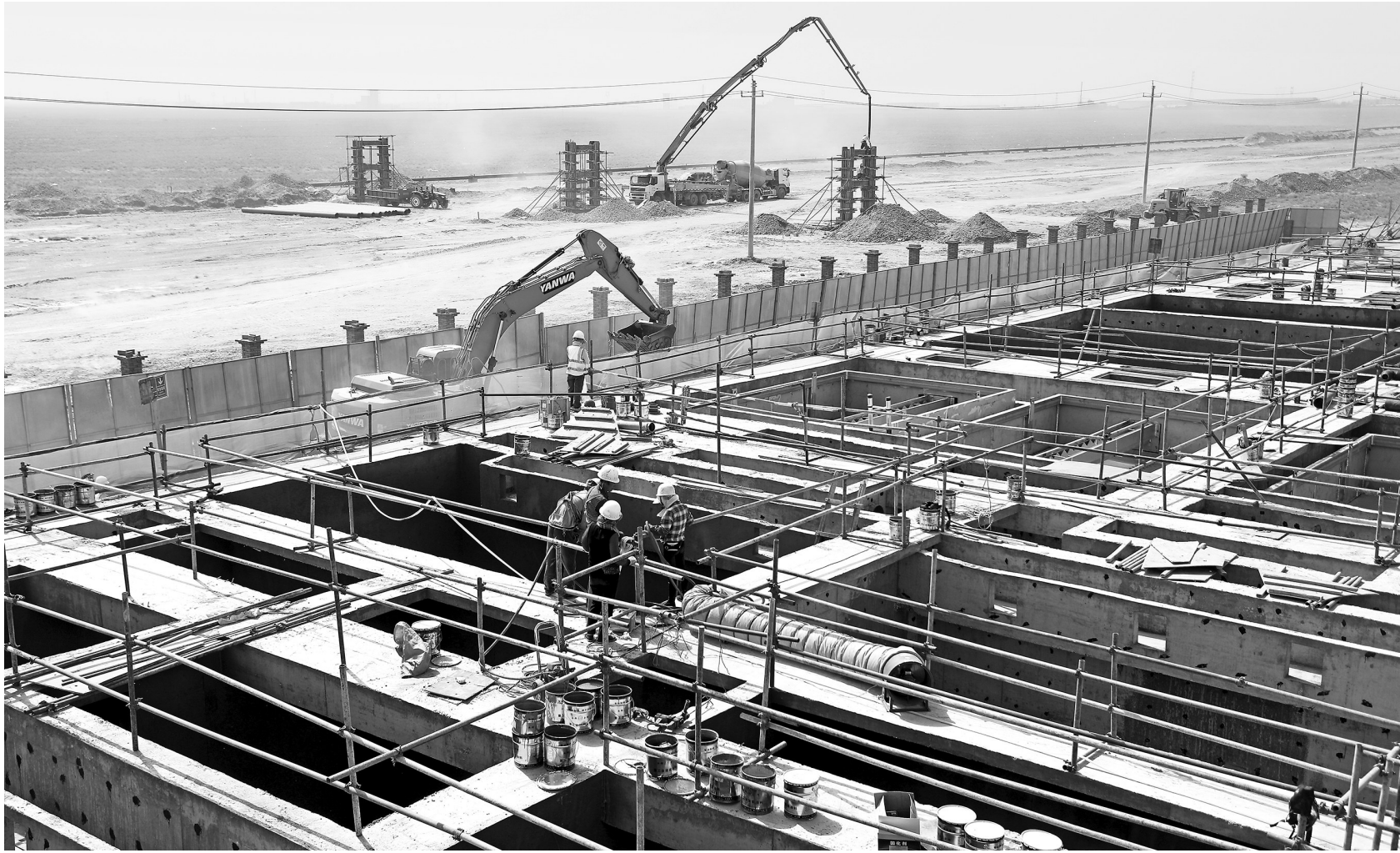
近日，在位于张掖市民乐工业园区化工产业园的化工污水处理厂项目建设现场，工人正加紧铺设污水管道。该项目建成后将成为解决化工产业园化工污水处理问题，同时可为工业园区提供绿化水源。
