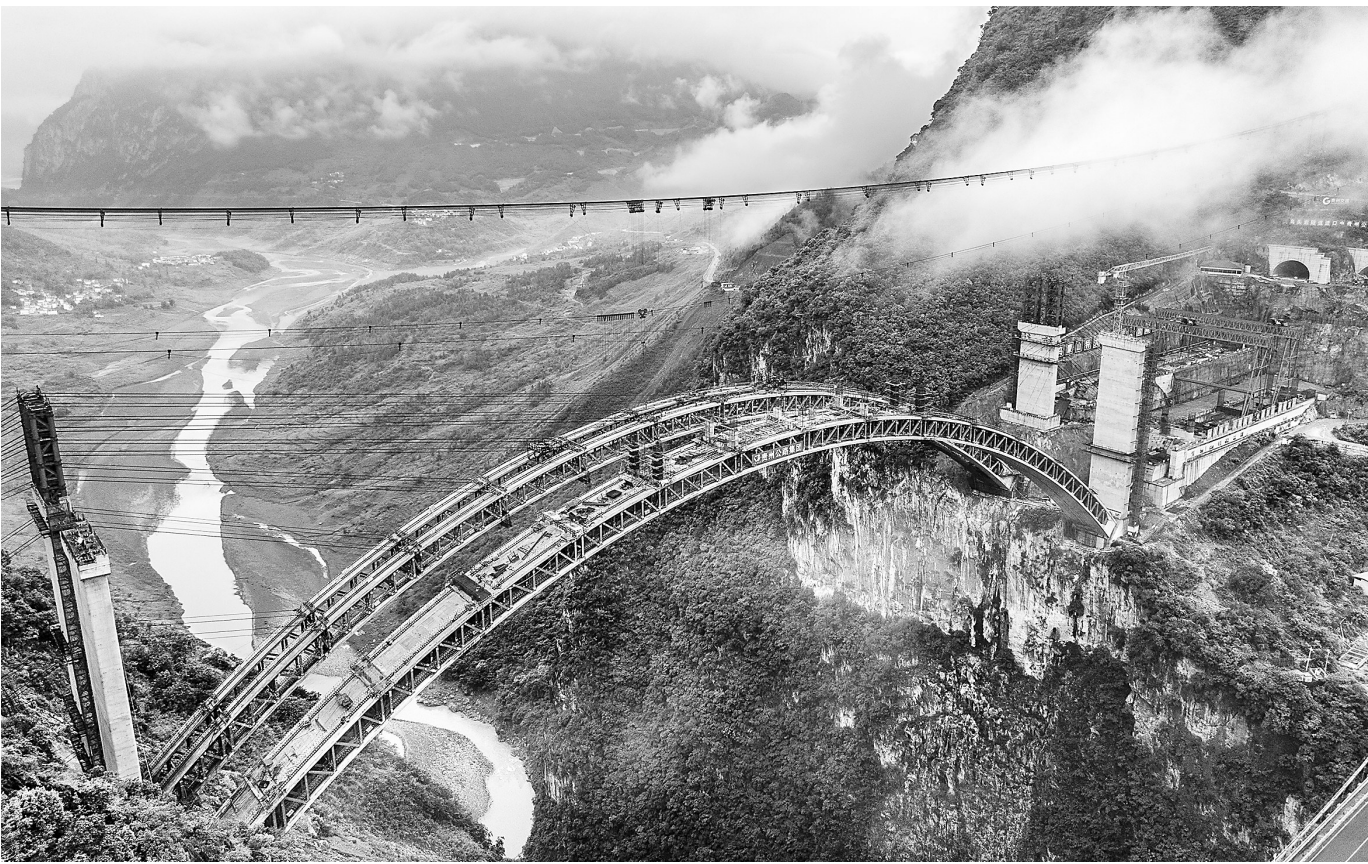
近日,纳晴高速乌蒙山大桥双幅主拱顺利实现合龙,乌蒙山大桥总体施工建设进入冲刺阶段。
