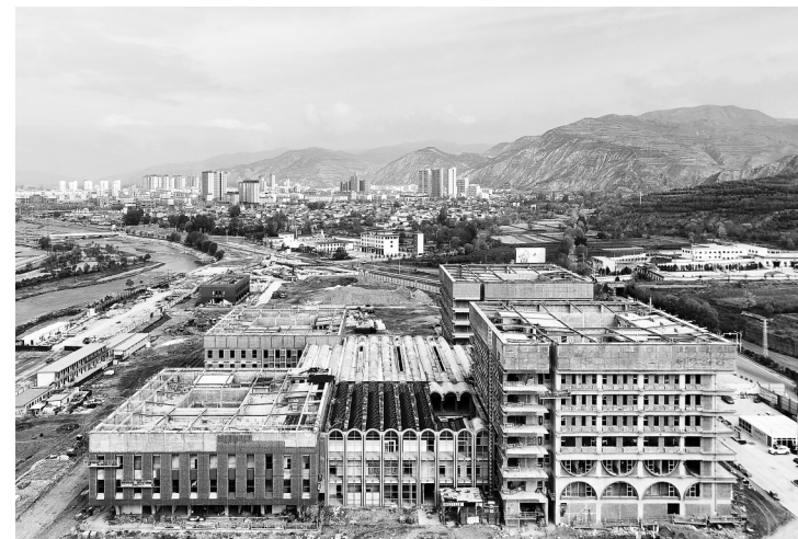
由中铁二十局市政公司承建的漳县人民医院整体搬迁项目一期工程正在加快建设。
