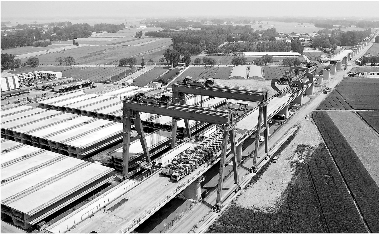
国家重点工程雄(安)商(丘)高铁河北段建设正稳步推进。图为5月23日,中铁十九局工人进行架梁作业。 新华社发
