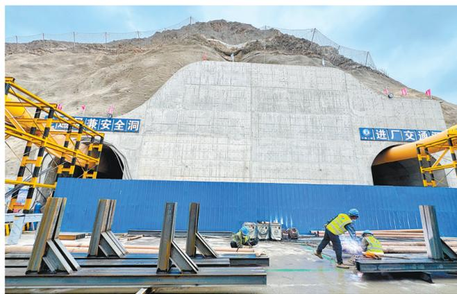
张掖抽水蓄能电站项目通风兼安全洞和进厂交通洞已经成型。
