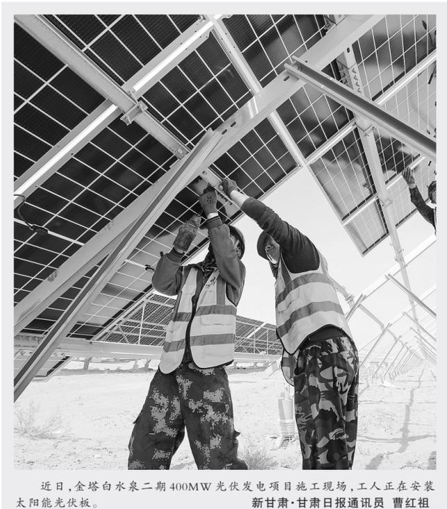
近日,金塔白水泉二期400MW光伏发电项目施工现场,工人正在安装太阳能光伏板。
