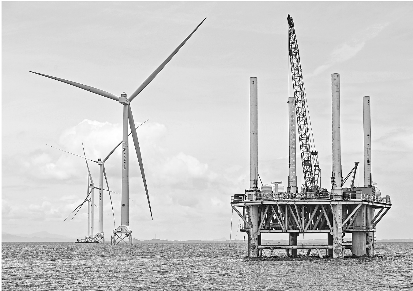
5月21日,广西首个海上风电示范项目——防城港海上风电示范项目A场址现场,海上风电场正在加紧建设。该项目将建设83台单机容量8.5兆瓦的风电机组。目前,已安装风电机组29台,其中15台已实现并网发电。新华社发
