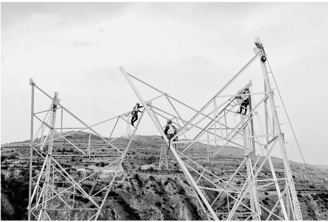
近日,在静宁县成成镇杨湾村,宁夏-湖南±800千伏特高压直流输电线路工程(甘青段)铁塔组的工人正在安装铁塔。据了解,该工程全长约1616公里,其中甘肃境内约184公里,新建铁塔347基。
