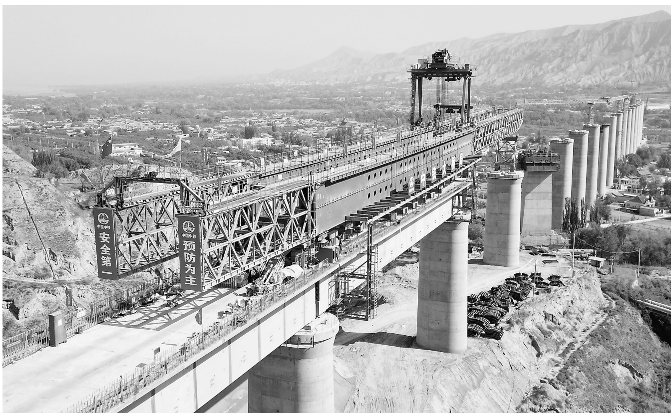
5月15日,兰州至合作铁路泄湖峡大夏河特大桥建设正在有序推进,该桥是三合铁路重点控制性工程,全长4721.45米。新甘肃·甘肃日报通讯员 史有东
