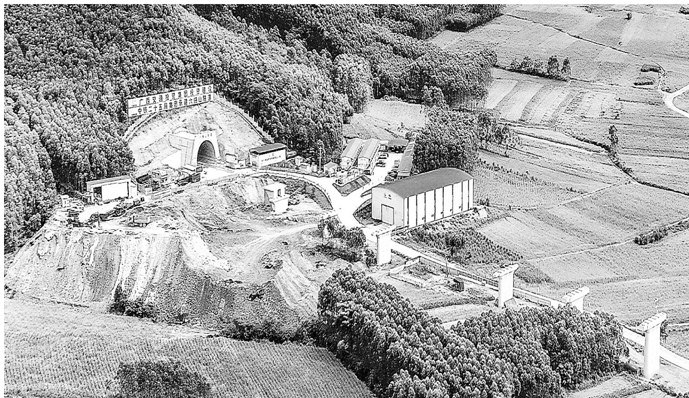
5月14日,广西柳州铁路首个中长途隧道——六绵山隧道顺利贯通,隧道全长2865米。 新华社记者 张爰林
