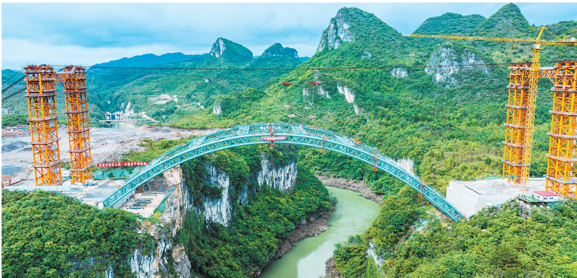
拉密河特大钢管拱肋合龙现场(5月10日报)。拉密河特大桥是贵阳至平塘高速公路重要控制性工程,大桥设计时速100公里。桥梁总长206米,净跨176米,是国内在建高速公路中最宽的不对称钢管混凝土拱桥。
