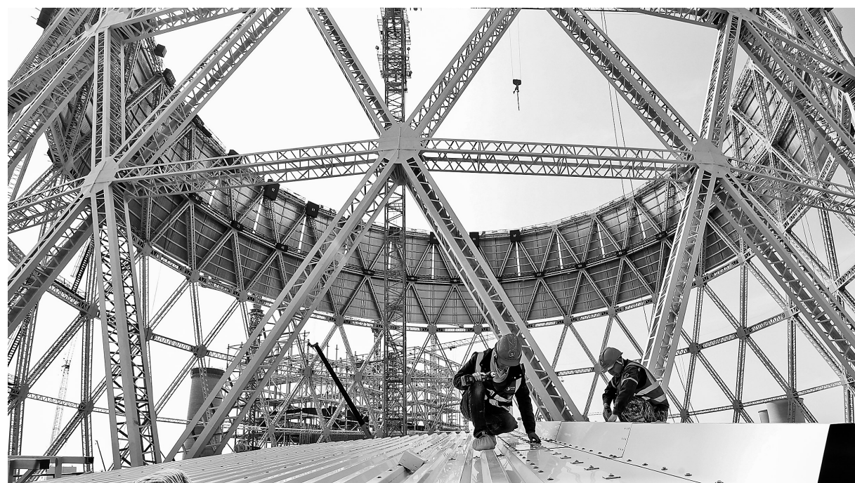
5月2日,在甘肃电投张掖发电公司2×1000MW燃煤机组扩建工程现场,工人正在加紧施工。新甘肃·甘肃日报通讯员 王 将
