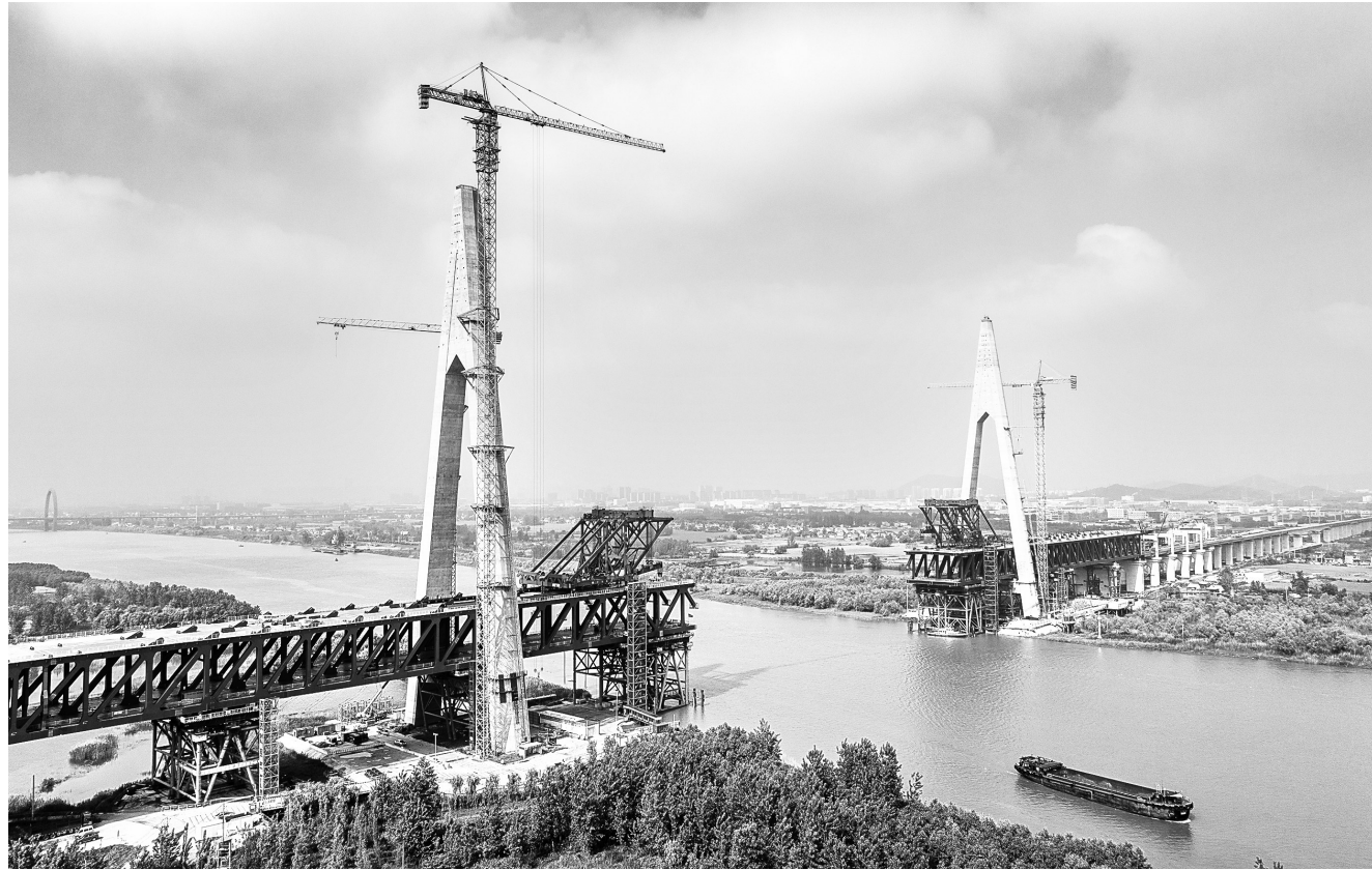
4月29日拍摄的巢马铁路马鞍山长江公铁大桥副航道桥施工现场。“五一”国际劳动节前,位于安徽省马鞍山市当涂县的巢马铁路马鞍山长江公铁大桥副航道桥施工现场一派繁忙,施工队员奋战在建设一线,确保重点工程建设进展顺利。 新华社发
