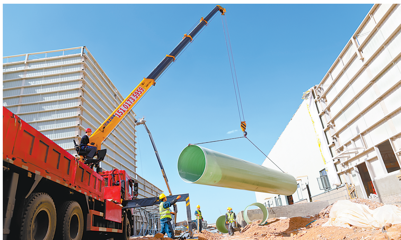
近日,位于张掖市高台县盐池工业园的张掖危废(固废)处置及资源化利用中心项目建设现场,工程建设者们正在加紧施工。
