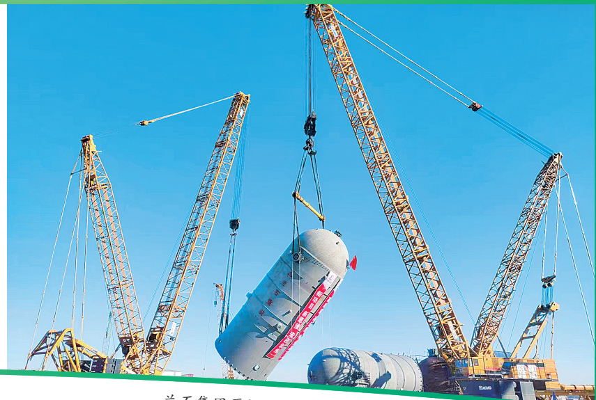
兰石集团严把质量关口,打造样板工程,推进项目快速落地。
