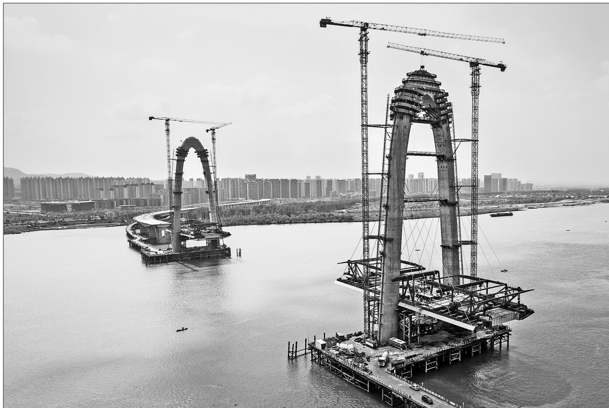
4月23日，由中交一公局承建的长沙兴联路大通道项目双塔斜拉桥主塔塔冠浇筑完成，标志着该项目双塔斜拉桥主塔顺利封顶。新华社发
