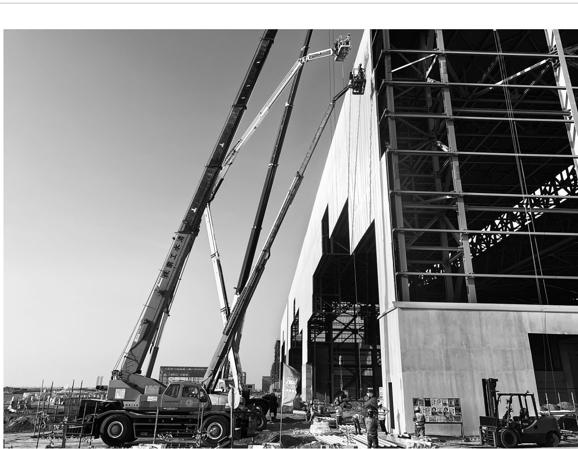
日前,中铁十八局集团(沙特)有限公司承建的沙特吉达机场维修机库项目A002机库、B001机库复合夹芯板外墙安装完毕,标志着项目施工进入了新阶段。图为吉达机场维修机库项目复合夹芯板外墙安装现场。
