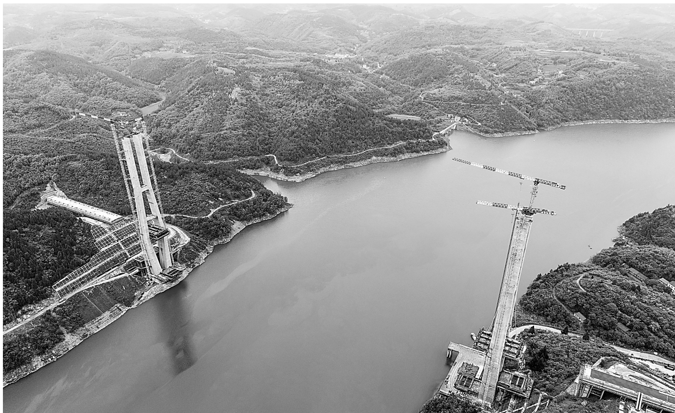
4月19日，西(安)十(堰)高铁汉江特大桥首对斜拉索成功挂设，大桥进入挂索施工阶段。图为汉江特大桥两岸主塔施工现场。新华社发
