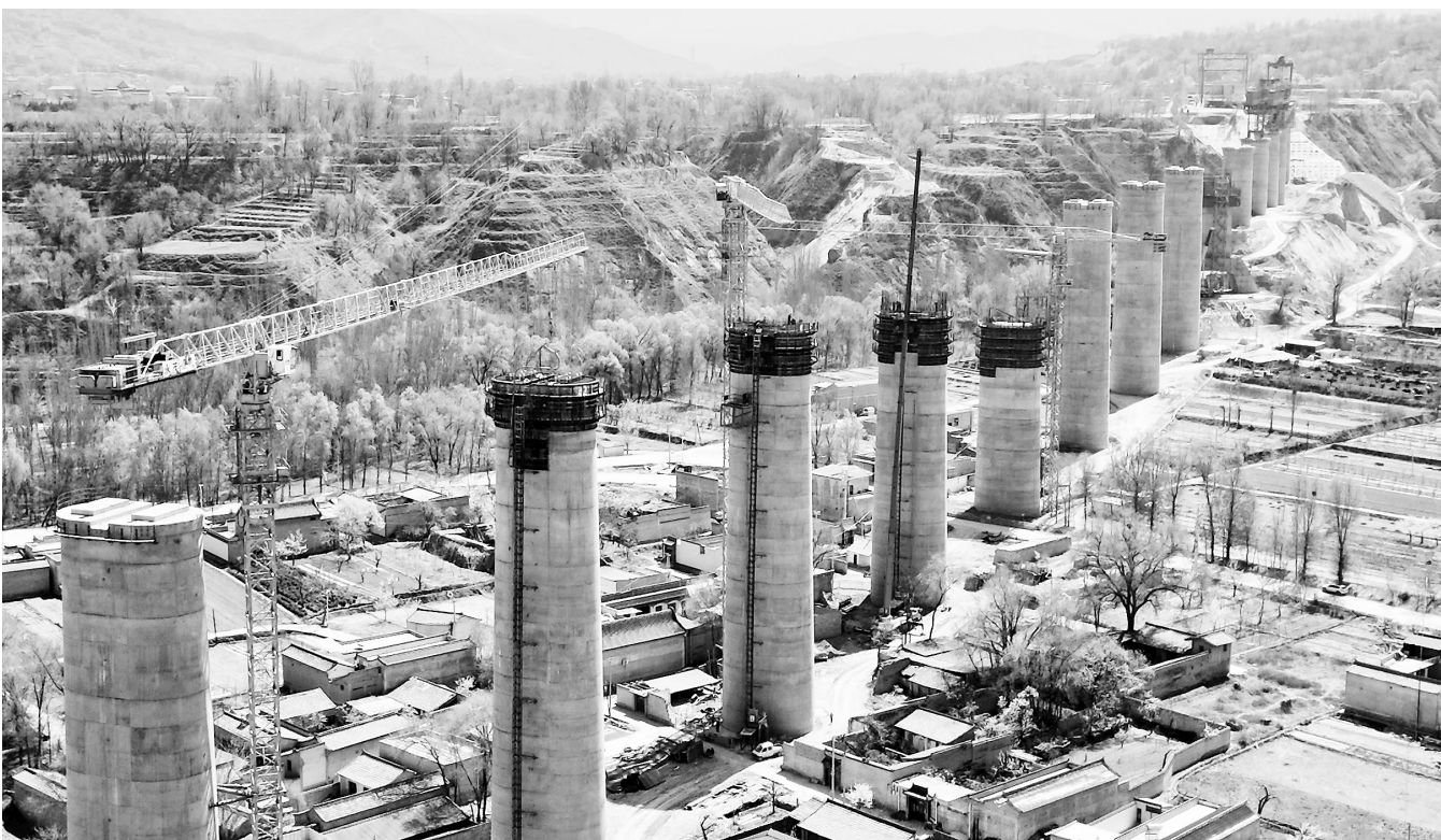
近日,兰合铁路(兰州至合作)建设现场,工人正在紧张施工确保工程建设进度。 新甘肃·甘肃日报通讯员 史有东
