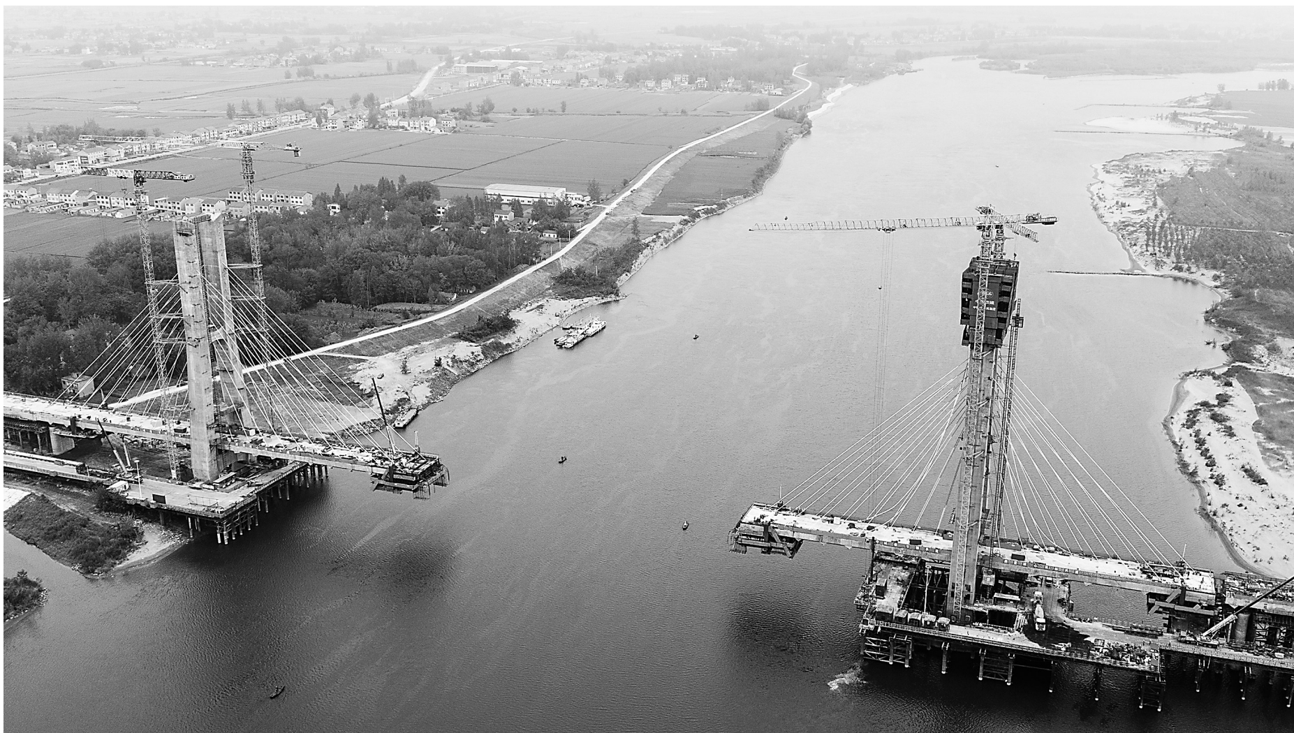
4月16日拍摄的沪渝蓉高铁武宜段钟祥汉江特大桥316号主塔施工现场。钟祥汉江特大桥横跨汉江,是沪渝蓉高铁武宜段的关键控制性工程。 新华社发
